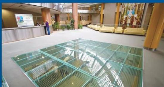
Важно помнить, что эти конструкции при эксплуатации должны выдерживать равномерно распределенную нагрузку не менее 400 кг/м<sup>2</sup>.
