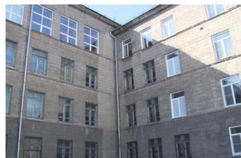
Внутренний угол здания (в местах примыкания одной части здания к другой под углом при расстоянии между оконными проемами менее 4 м по горизонтали)
